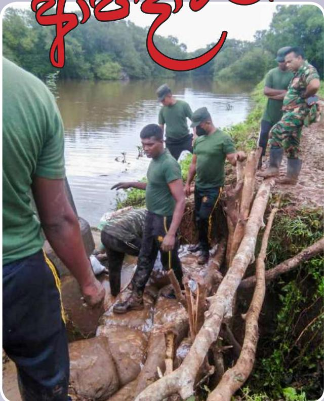
ශ්‍රී ලංකා සිංහ රෙපිමෙන්තුවේ 15 වන බලඡැණිය ස්ථානගත පුද්ගලයේ පිහිටා ඇති වින්නකුලම් වැව පසුගිය ඇදහැගුණු අධික වර්ෂාව හේතුවෙන් පිටාර ගැලීමේ තත්ත්වයට පැමිතා වින් වැව්බැමිමට හානි සිදුවී කැසී යාමේ අවබුහමකට උක් විය. විම අවස්ථාවේදී වහා ක්‍රියාත්මක වූ එකක හට පිරිස් අනුදෙන නිලධාරිගේ උපදෙස් මත කැසියාමේ තර්ජනයට ඔක්වූ ස්ථානය පිළිසකර කරමින් වැව් බැමීම කැවියාමේ අවධානමෙන් මුදා ගන්නා ලදී.
